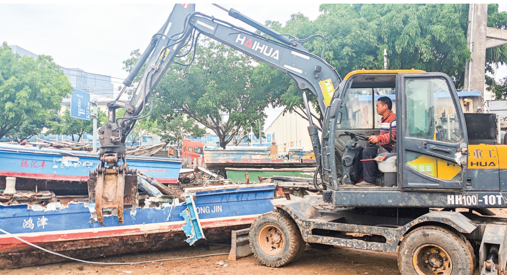
挖掘机拆解涉渔“三无”船舶。杨天宇 摄
