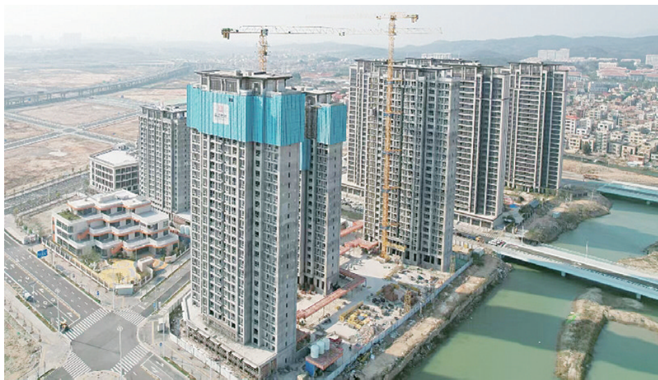
东园公寓二期正在进行室内外装修。
