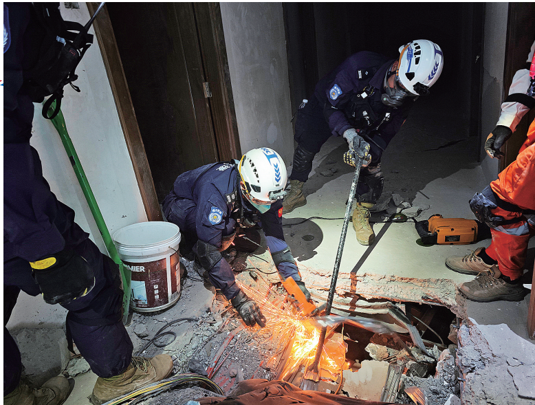
厦门市曙光救援队在缅甸开展救援行动。
