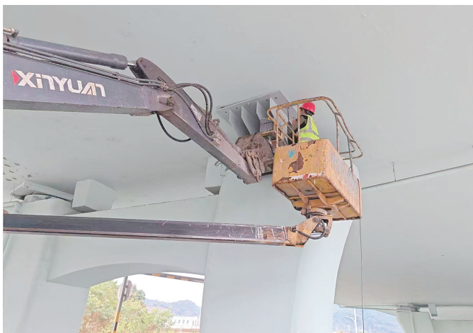
工作人员正在G324复线官浔溪大桥安装防落梁纵向限位装置。市交通局桥隧中心供图
