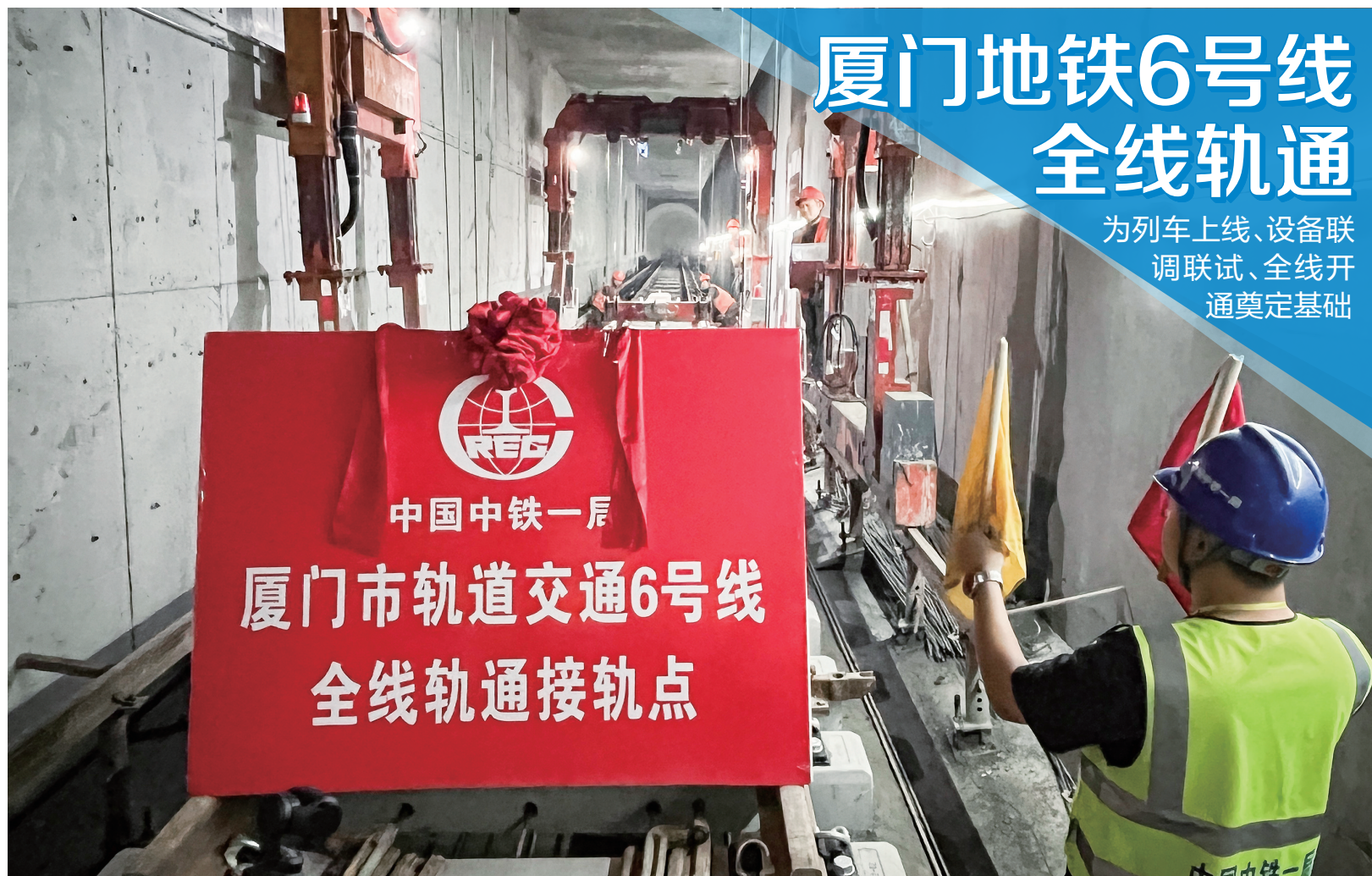
厦门市轨道交通6号线全线轨通。林甄玉 摄
