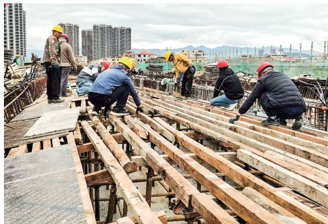
汀溪西路(凤岭二路一同翔大道段)工程施工现场。
