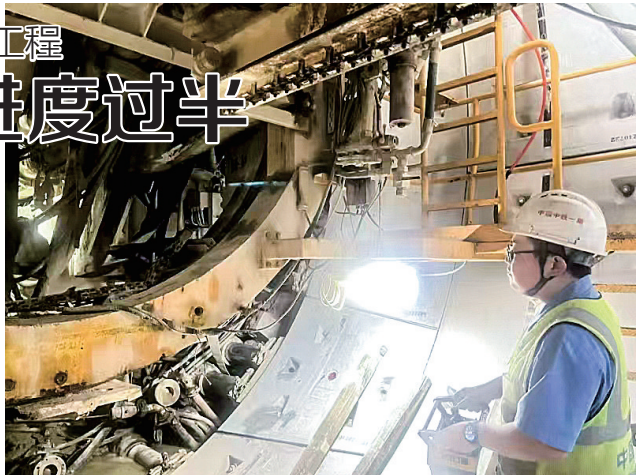
施工人员操作盾构机向着隧道深处“挺进”。
