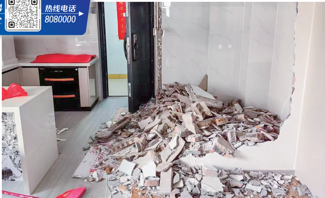
思明区城管执法局梧村中队曾安排工人拆除701室建成的厕所墙体。(图片来自厦门12345平台)
