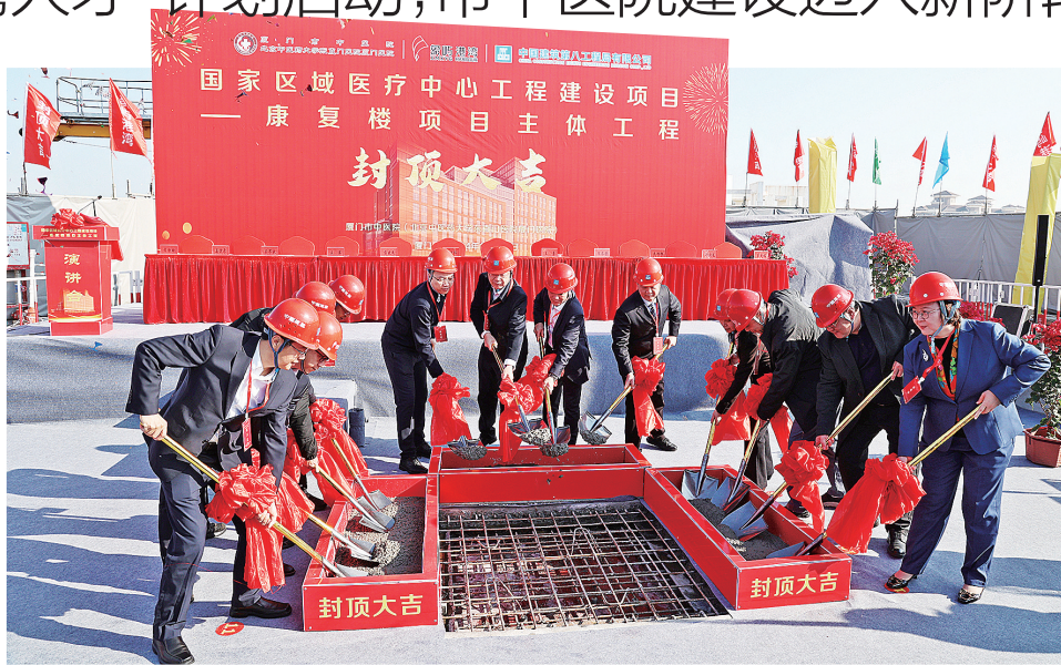
厦门市中医院二期康复楼工程迎来主体封顶。 记者 叶嘉健 摄
