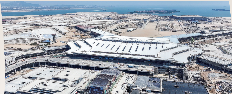
厦门翔安国际机场航站楼。通讯员供图
