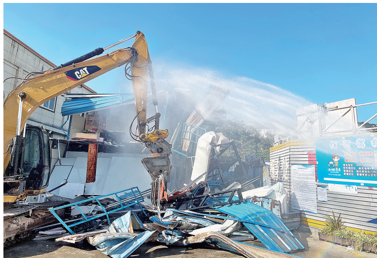
C6地块拆除现场。记者林爱玲摄
