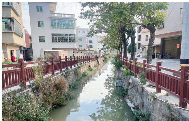
汀溪左干渠内厝段恢复通水。记者 张雅雯 摄
