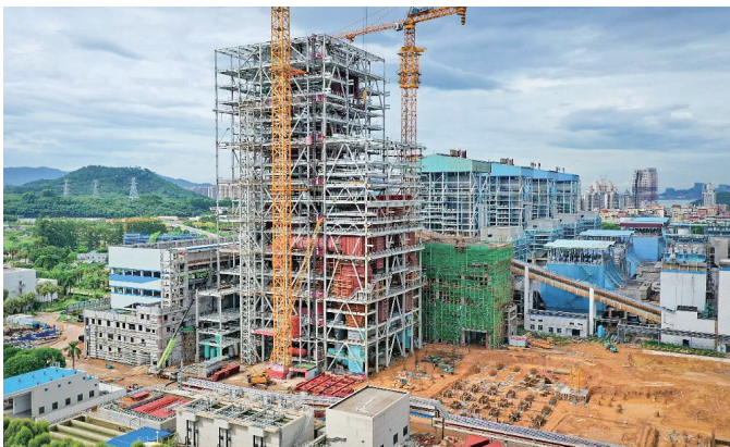
华夏电力一期机组等容量替代项目主体结构已封顶。
