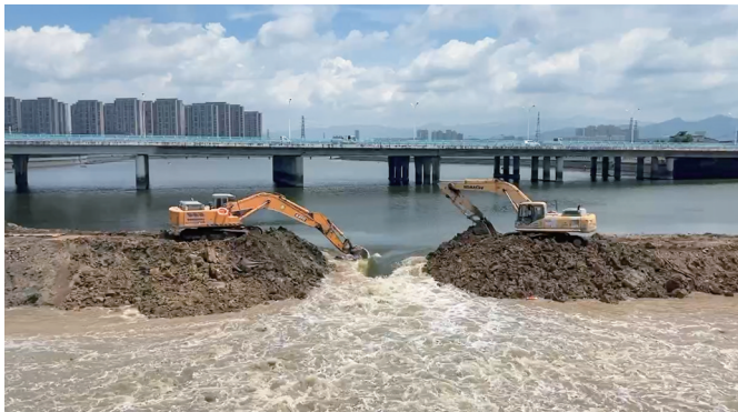
浦声水闸围堰本月底拆除完成。记者 洪艳艳 摄
