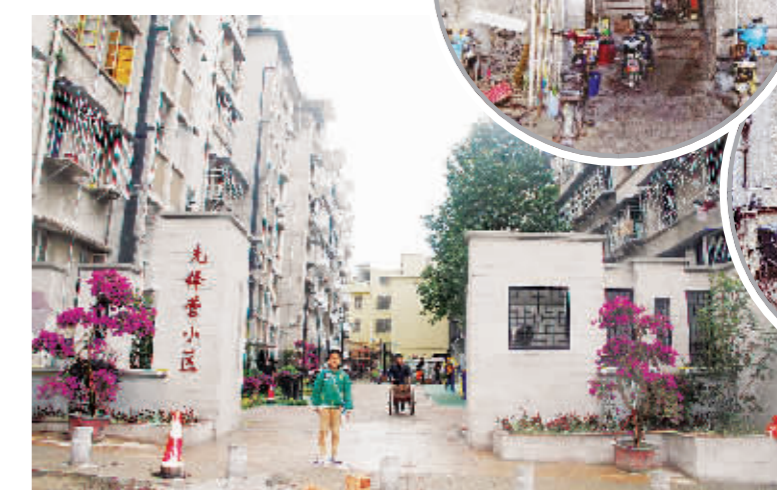
改造后,小区大门干净整洁。街道供图P188254654
