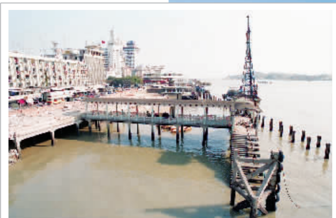
1997年鹭江道改造施工。姚凡 摄 P188306413
